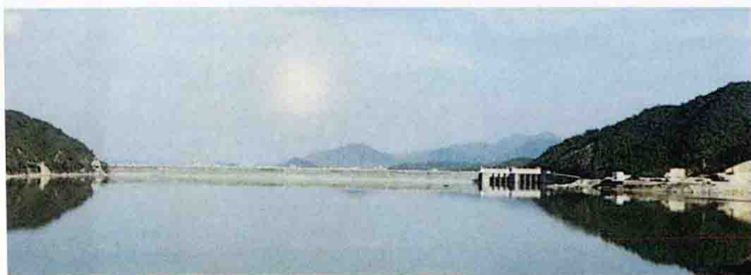
大坝内景，右为公山坡，左为姥山坡
