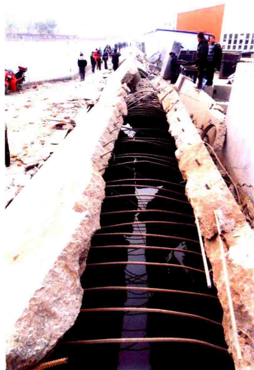
↑ 2013 年 11 月 22 日 10 时 30 分许，位于山东省青岛经济技术开发区的中石化东黄输油管道发生泄漏爆炸特别重大事故。截至 25 日 7 时，事故造成 55 人死亡、9 人失踪，原油泄漏入海。/ CFP 供图
