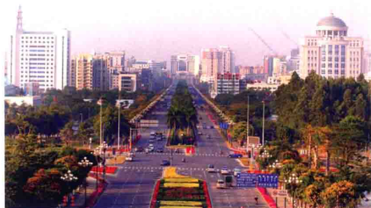
1992年建成的兴中道，全长3.5千米，宽50米，中心绿化带宽11米，中山市新十景之一——“兴中缀锦”就位于此，是东区重要景观路（摄于2002年5月）。
