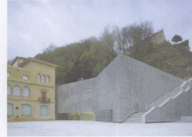
85. San Telmo Museum Extension Nieto Sobejano Arquitectos San Sebastián, Spain, 2011
