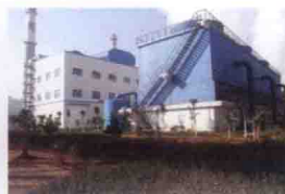
煤气综合利用
