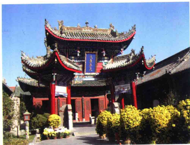
開封山陝甘會館牌坊
