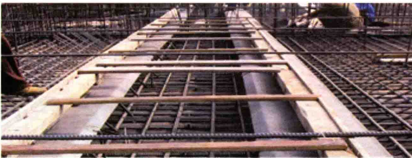
图1.1-4 筏板后浇带留置实例图
