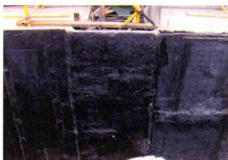
图1.1-12 地下室后浇带预制盖板安装实例图
