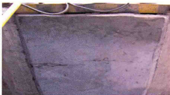
图1.1-12 地下室后浇带预制盖板安装实例图
