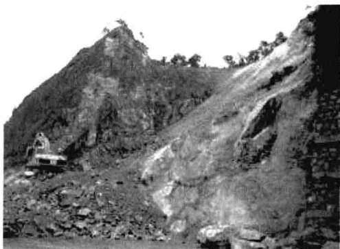
图 1-8 路堑边坡崩塌
