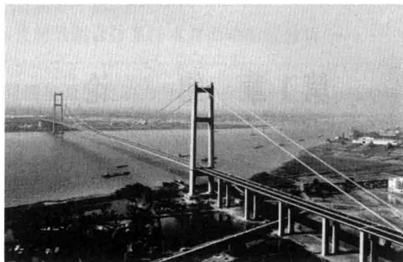
b)润扬长江公路大桥南汊悬索桥(公路钢箱梁桥)
