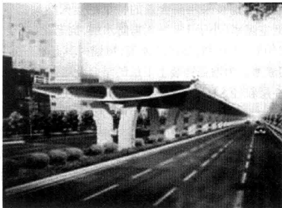
e) 厦门仙岳路西段高架桥(混凝土箱梁桥)
