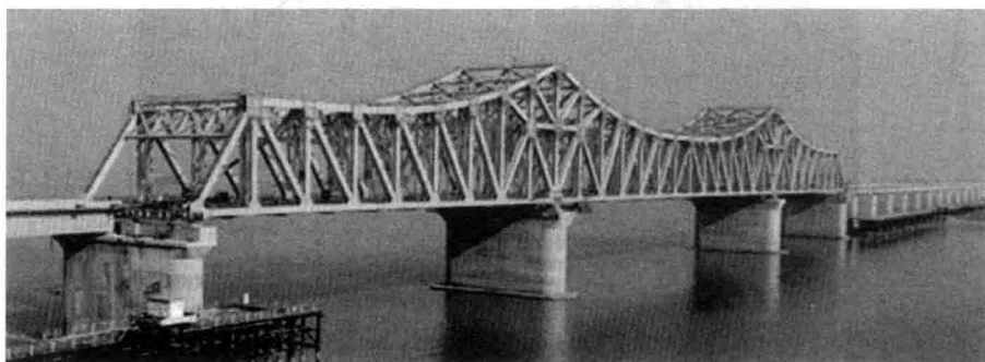
d)东新赣江特大桥(铁路钢桁架桥)
