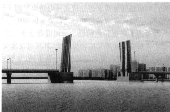
c)天津海河响螺湾开启桥(立转式开启桥)
