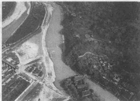
图1-1 都江堰水利工程空中俯视图
