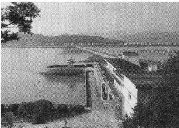
图 1.3 江厦潮汐电站
