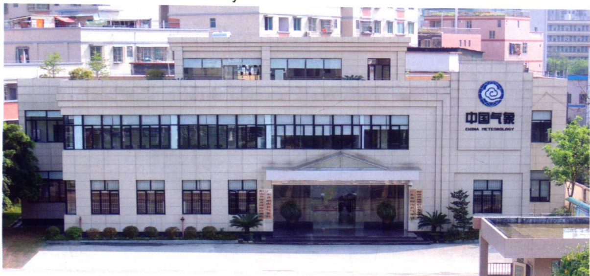
2011 年建成的二层半 960 平方米办公楼
