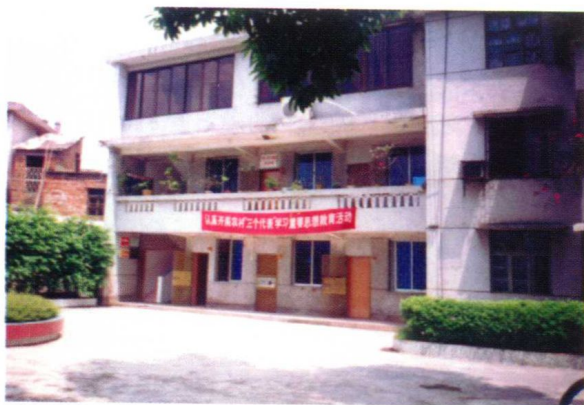
1989 年建成的三层办公楼
