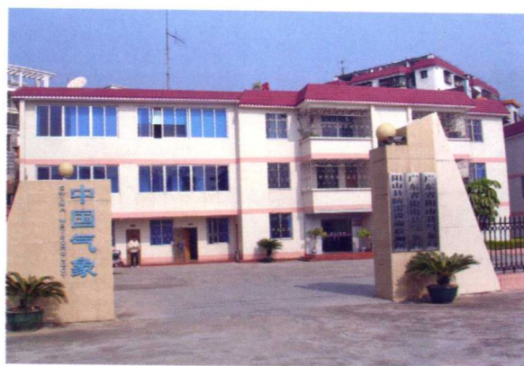
2007 年重新装修的办公楼
