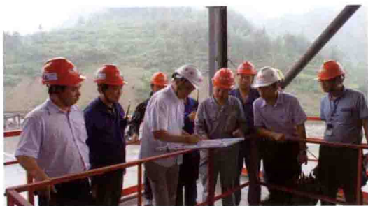
在重庆水泥公司，刘永行给大家讲解施工工艺流程图，首创直接从山里用皮带运输矿石到工厂的工艺。利用山与工厂的600米落差，实现动力节约，并利用皮带下滑的动力发电。
