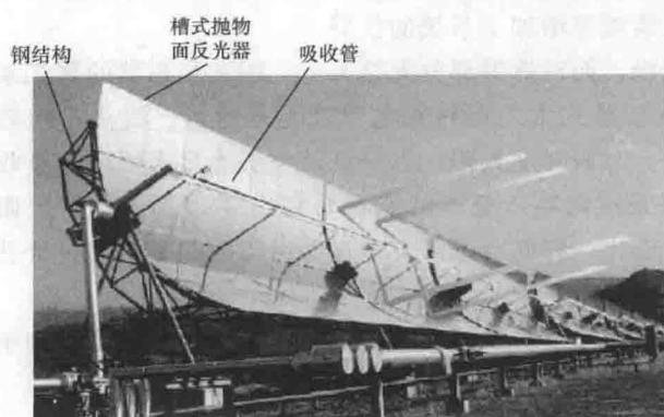
图 2.2 衍架式单元 (Eurotrough) 聚光器阵列
