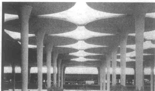
图 1.1 无梁楼盖结合采光的室内空间造型
