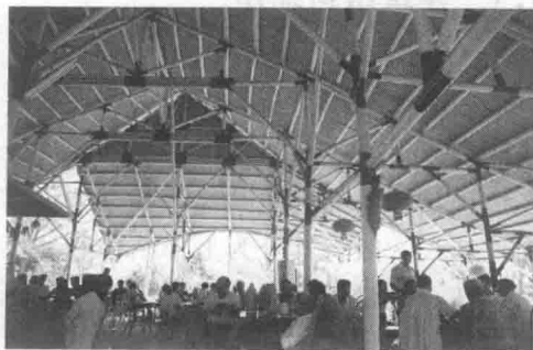
图 1.2 竹骨架斜坡屋顶室内空间造型
