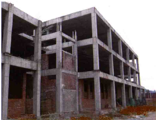
图 1-5 某框架结构的在建实验楼
