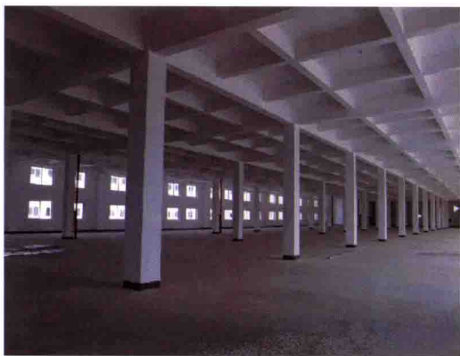
图 1-4 某框架结构的在建教学楼
