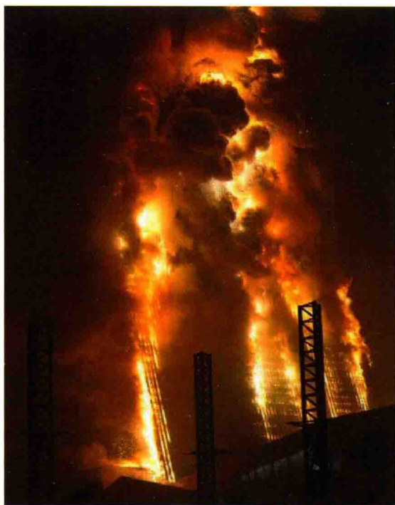
图1-22 央视新大楼发生火灾
