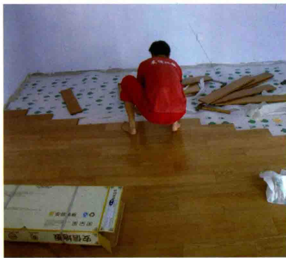
图 1-11 铺防潮垫层和复合木地板
