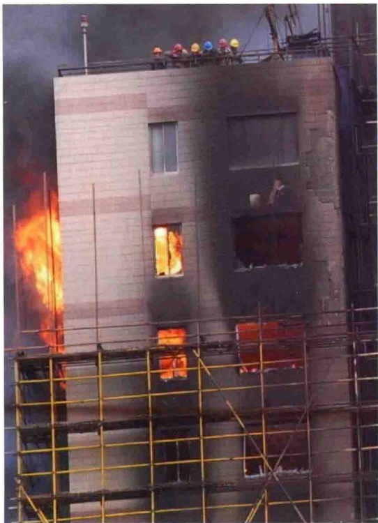
图 1-17 近看上海某高层住宅火灾
