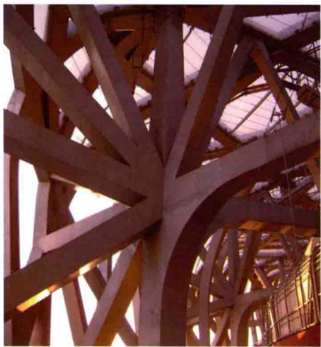
图 1-6 鸟巢钢结构连接示意
