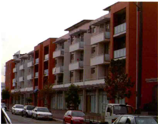
图 1-2 某砖混结构的居民楼
