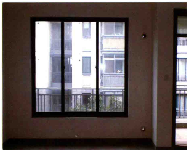
图 1-9 砖混结构的阳台窗下墙不能拆
