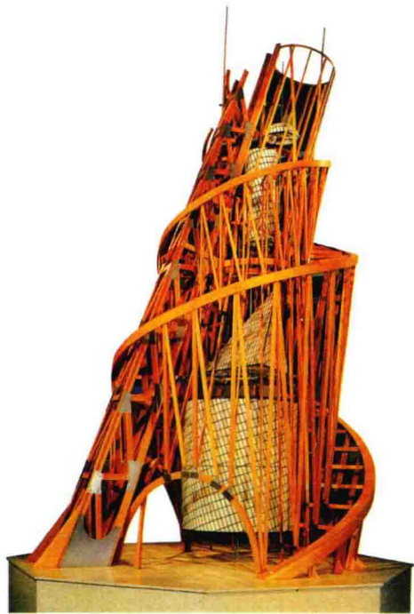
图1.2 塔特林在1919年受十月革命政权的委托，创作《第三国际纪念碑》；他所设计的纪念碑，实际上是技术和艺术结合的一座纪念塔；他把艺术和实用融为一体，将塔的内部和外部结合，组成一个螺旋状高塔，并采用铁和玻璃两种材料筑成；设想中，这座400多米高的碑身将矗立在莫斯科广场；虽最终未能建成，但作为当年的精神象征，这个方案及模型给人留下了深刻印象，成为“结构主义”功利精神的标志；现被收藏在圣彼得堡俄罗斯国立博物馆内
