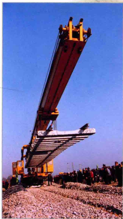
新淮铁路机械化铺轨作业现场
