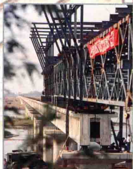
铁路大桥建设工地
