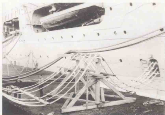
正在为美国塔科马市提供电力的“列克星顿”号，从船体接出的电源线将电力输往岸上的变电站
