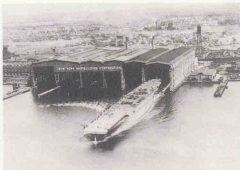
在纽约船厂下水的“萨拉托加”号航母。此时它仅仅完成舰体，上层建筑还未安装
