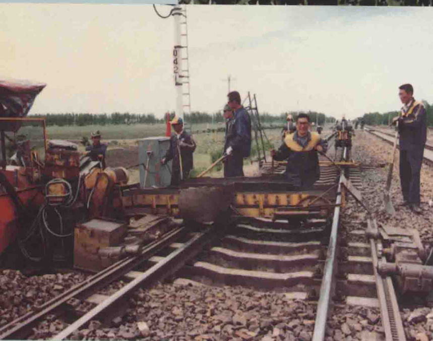
工务中修作业
