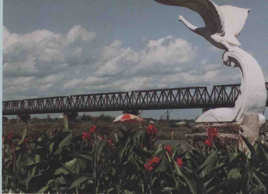
哈尔滨松花江铁路大桥
