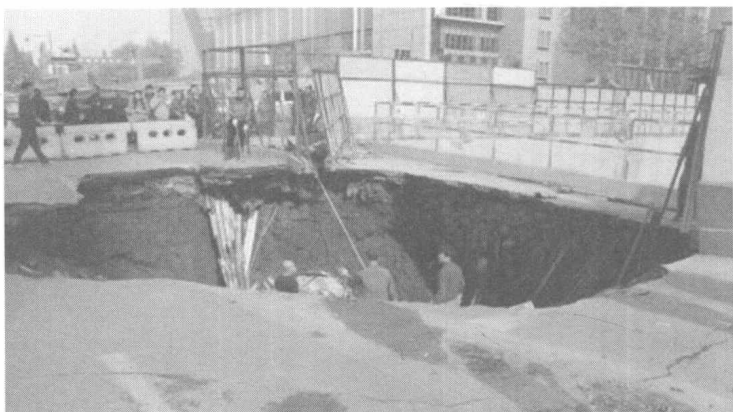
图 1-10 地面塌陷成大坑
