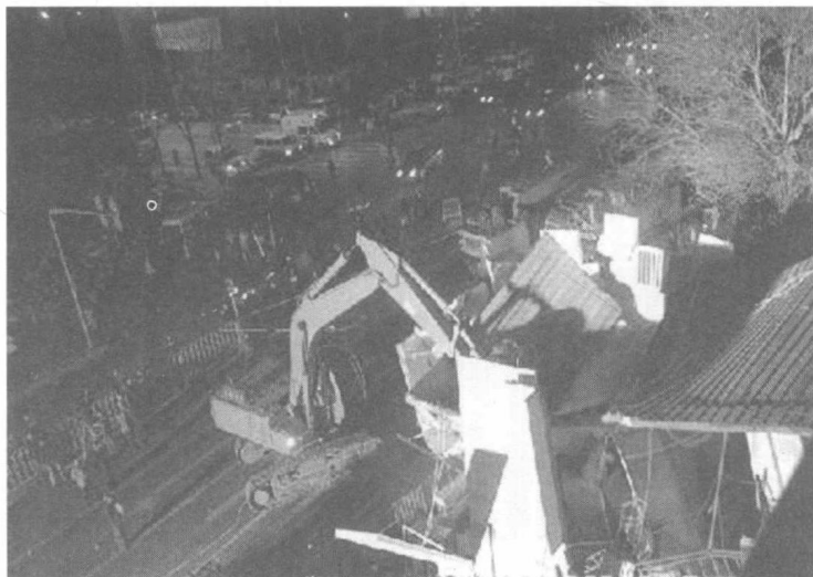
图 1-5 两层活动房坍塌
