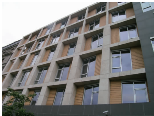
图 1-1-27 某办公楼外窗
