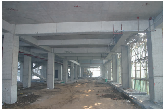
图 1-1-21 正在施工中的楼面
