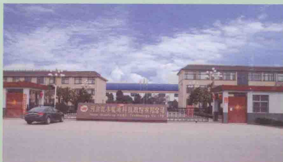
河南乾丰暖通科技股份有限公司厂景
