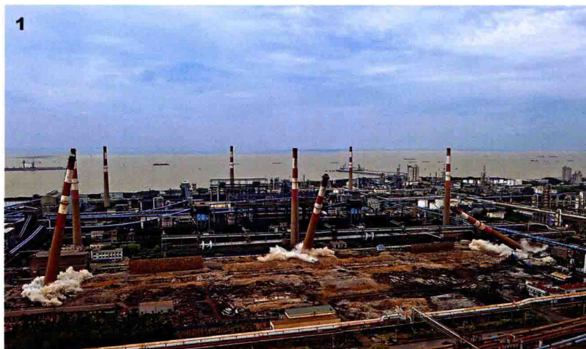
1 8月18日, 宝钢股份一期焦炉大修改造工程实施烟囱爆破(姜为强 汪杰 摄)
