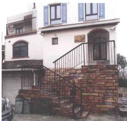
主入口，需上一个楼梯，进去是餐厅
