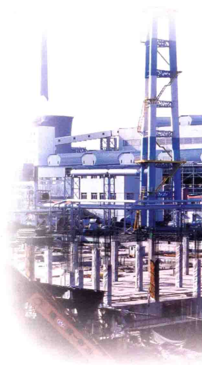
通钢 120t 转炉工程
