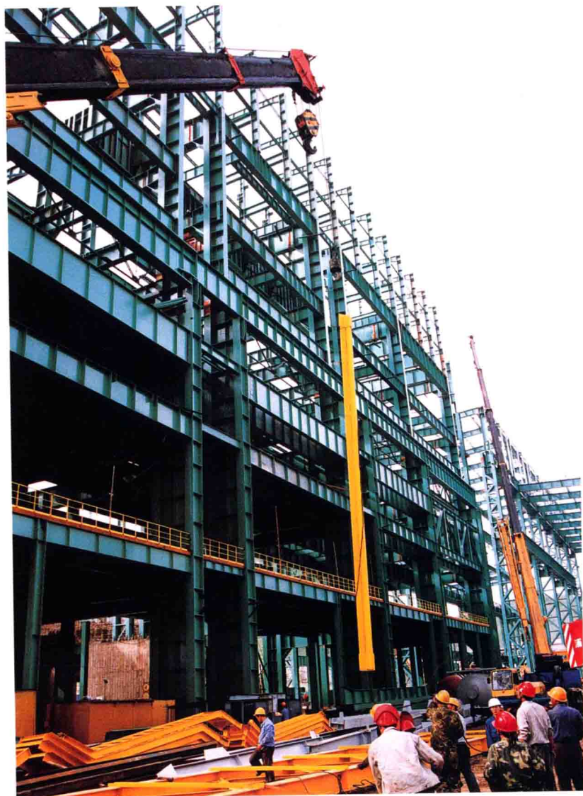
通钢 120t 转炉工程
