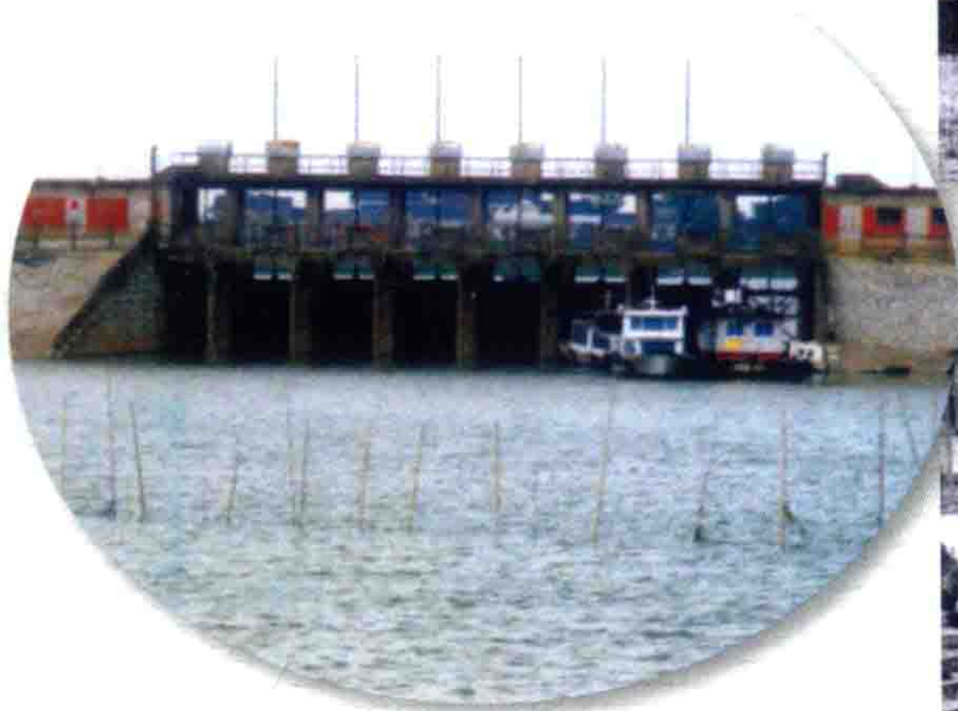
杨家湾水利枢纽节制闸
