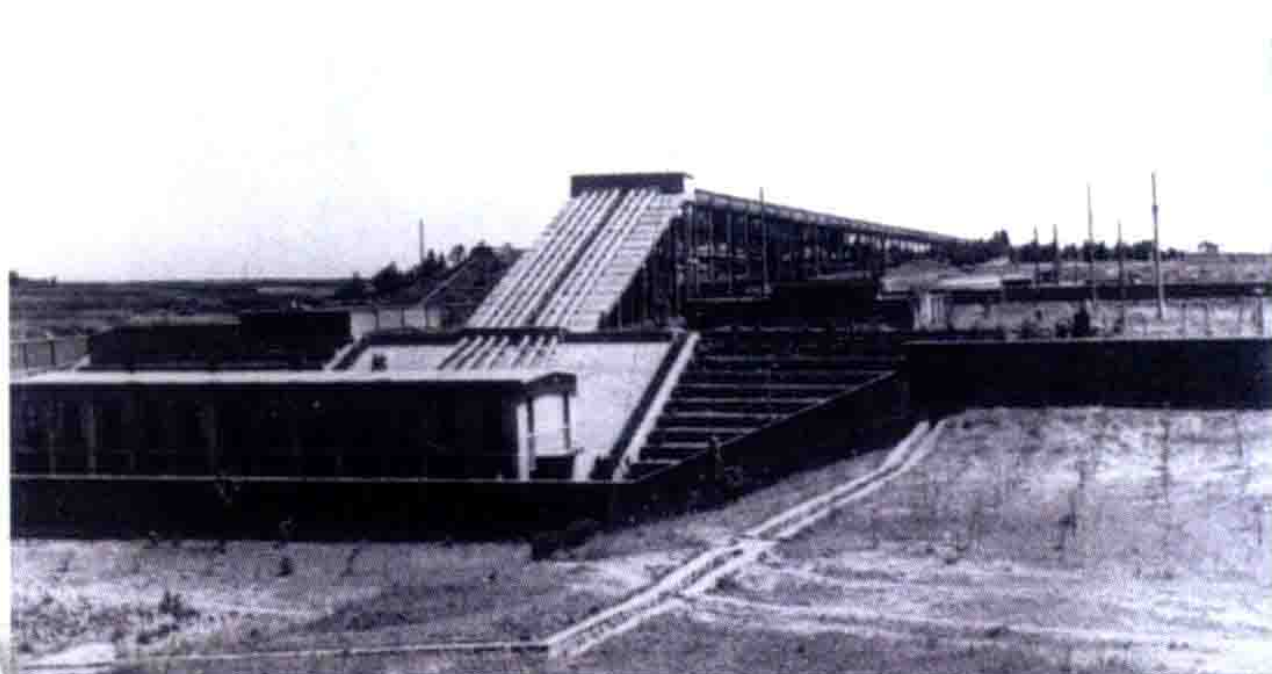
淳东抽水站南站
