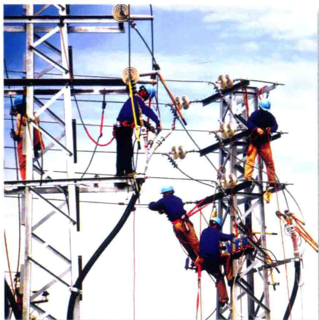
供电人员高空作业
