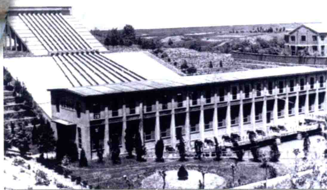
淳东抽水站北站
