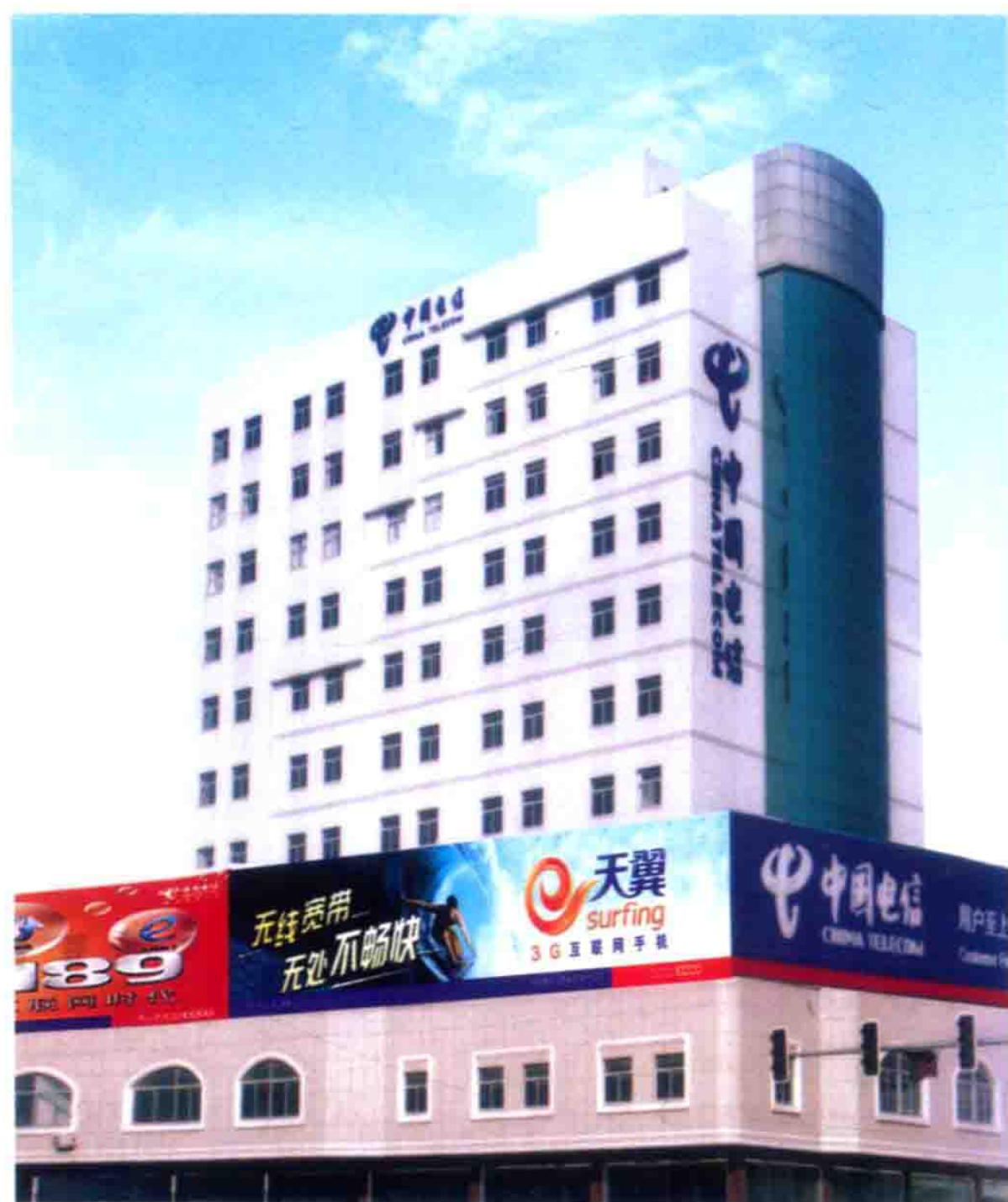
江苏省电信有限公司高淳县分公司办公大楼
