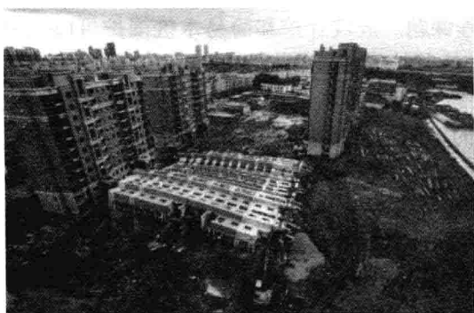
图1-3 上海新建楼房倒塌
