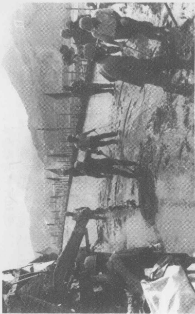
纵向围堰上纵堰外段8—9块达到设计高程。
