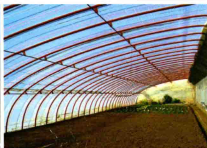
彩图 1-4 钢骨架日光温室内部 (a)
