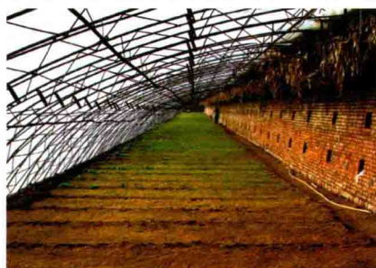
彩图 1-5 钢骨架日光温室内部 (b)
