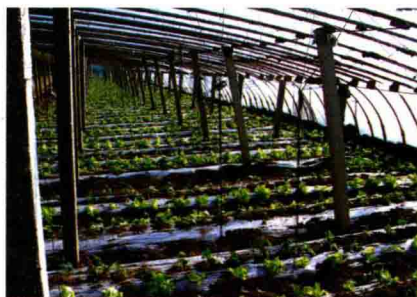
彩图 1-7 竹木骨架日光温室内部
