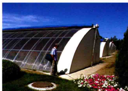
彩图 1-3 钢骨架节能日光温室外部
