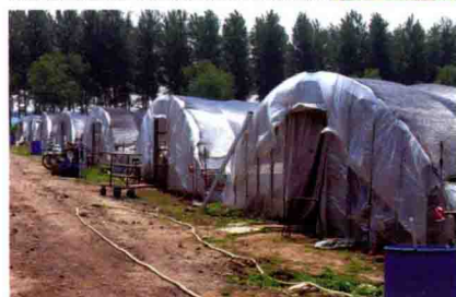
彩图 1-11 镀锌钢管装配式塑料棚外部
