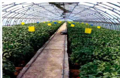
彩图 1-12 镀锌钢管装配式塑料棚内部
