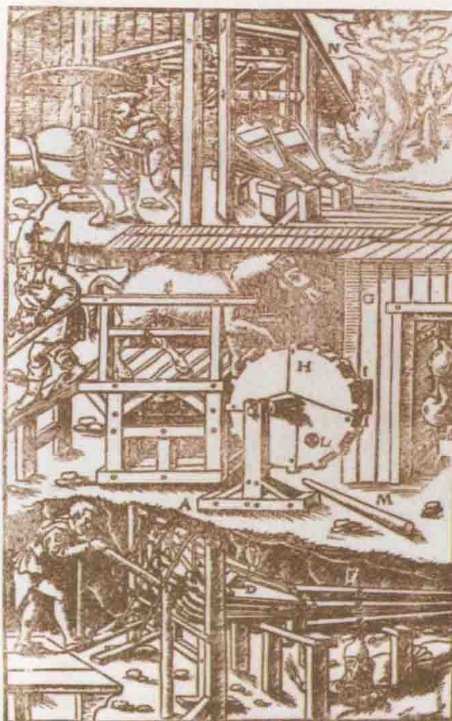
『デ・レ・メタリカ』の挿絵から。人力による鑛(下)とウマの力を利用した鑛(中央右)
