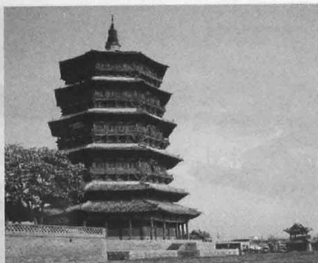
图 1-5 山西应县木塔
