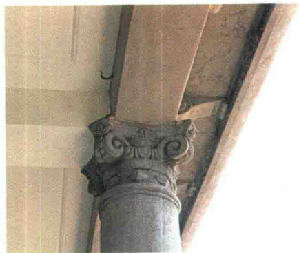
庆王府主楼外廊柱子
