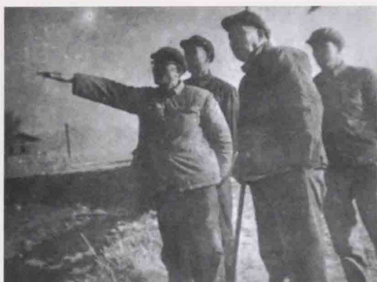
1969年12月，李培福（前排左二）在景电 一期工程草土围堰施工现场
