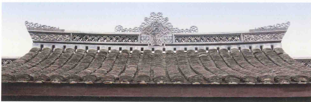
会馆屋顶正脊
