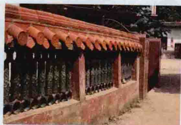
居民用陶瓷产品修建的庭院围墙
