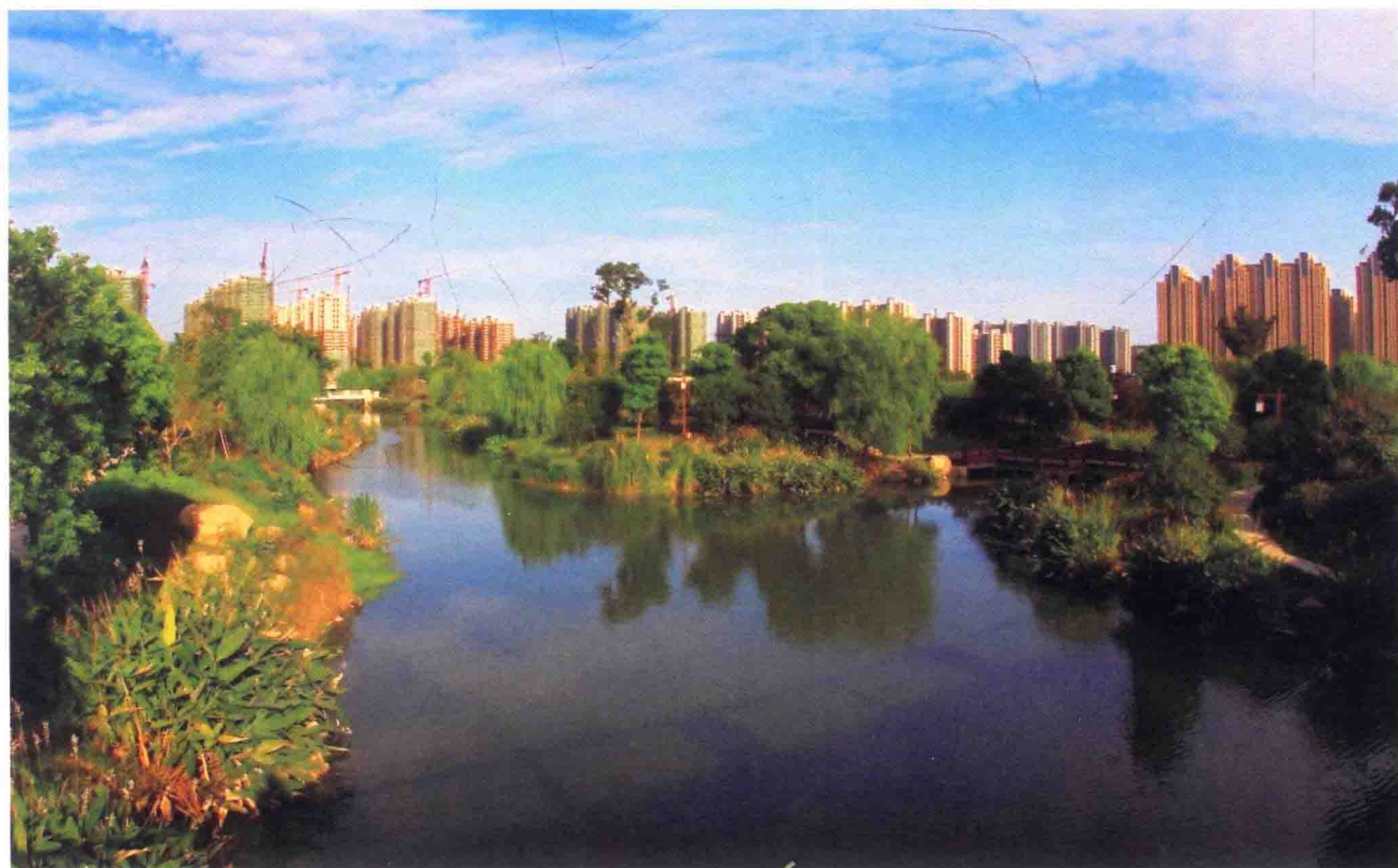
建设中宁静的城市（2013年·临平） 林天立 摄
