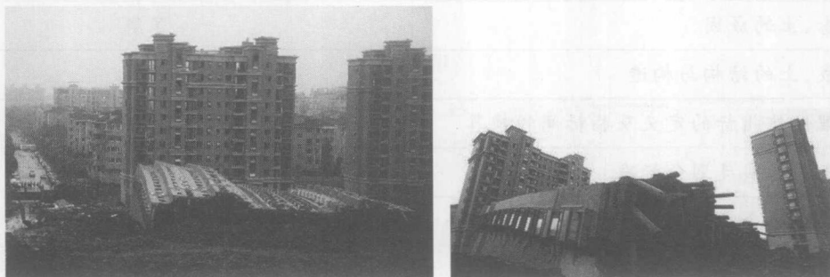
图1-2 上海市“莲花河畔景苑”7号楼倒塌事故图
