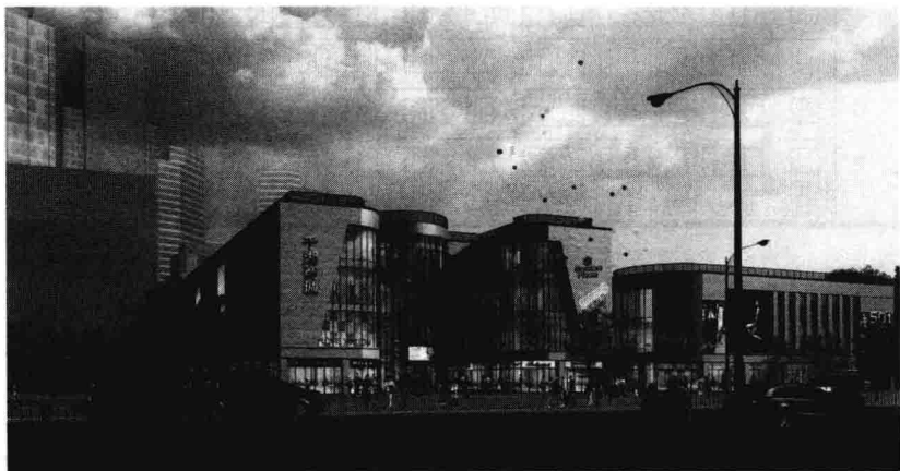
图 1-12 大量性建筑——大型商场
