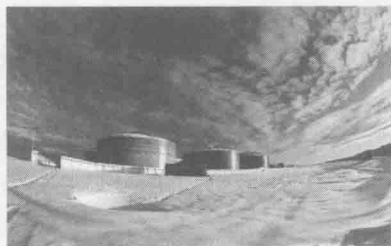
图 1-5 杜邦存储基地
