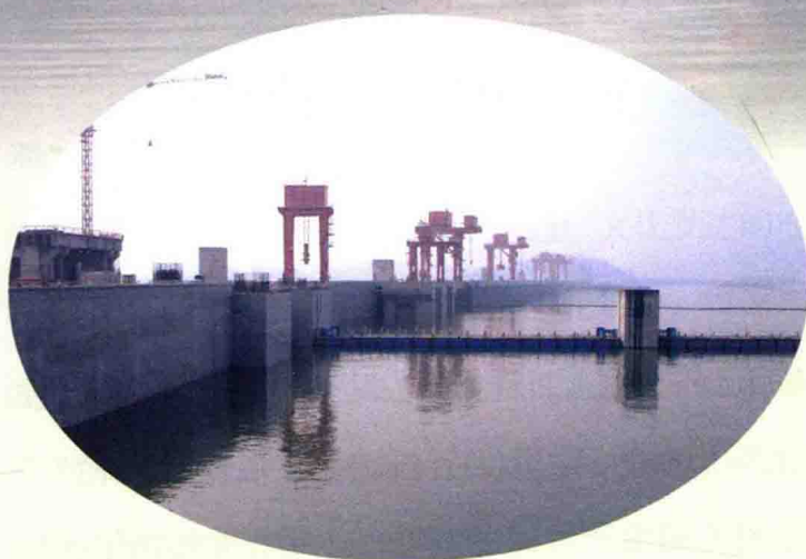
水利水电枢纽工程 (马牧源 摄)
