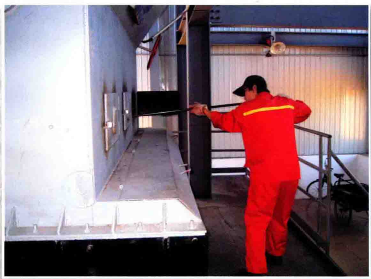
油改煤注汽工程
