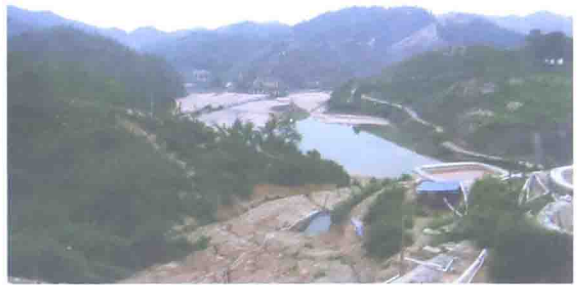
彩图 13 龙南稀土矿的老车间（左）及雨水冲刷尾砂形成的淤泥河床（右）
