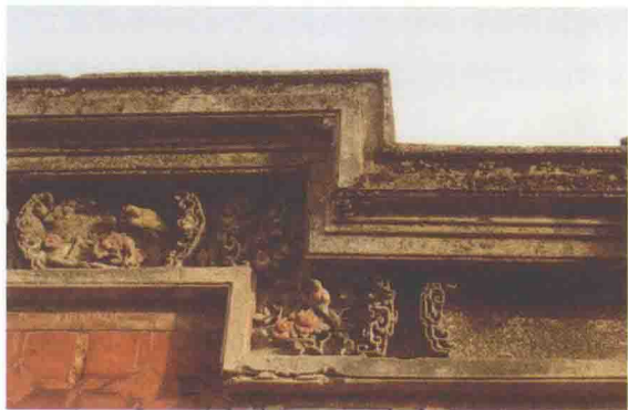
图1-5 传统建筑的屋檐装饰
