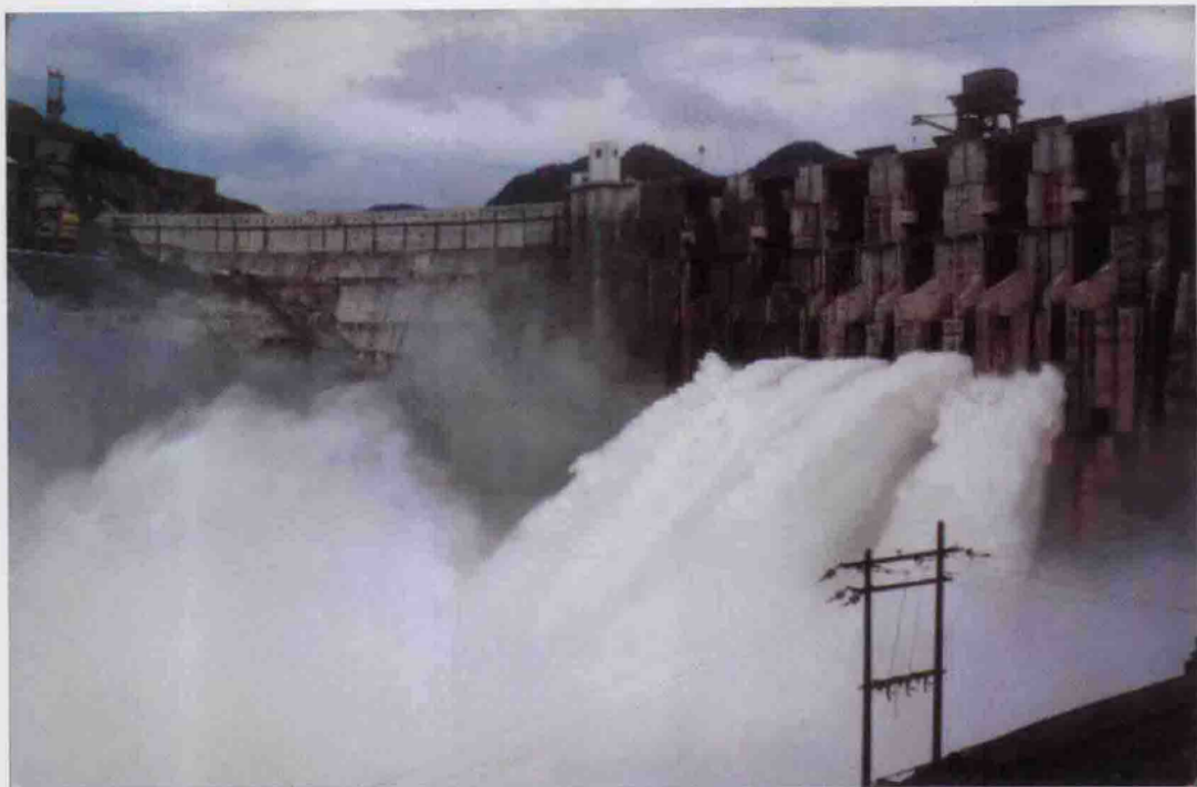
隔河岩水电站
