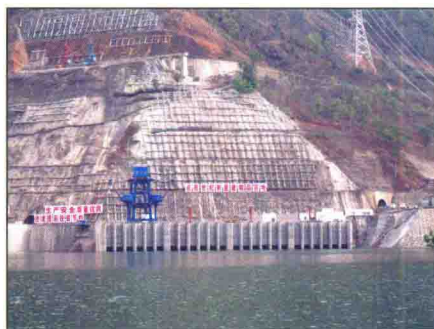
电站进水口高边坡
