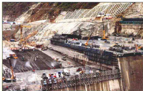
大坝碾压混凝土浇筑
