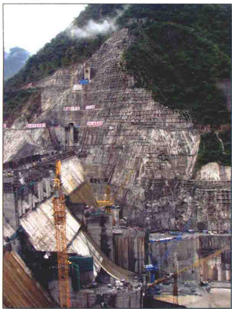
左坝肩高开挖边坡
