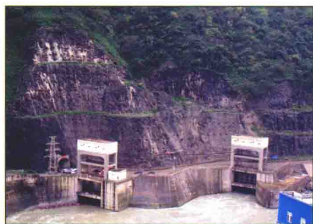
尾水洞出口边坡
