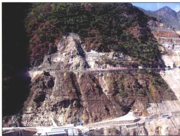
右岸4号卸荷拉裂岩体边坡处理
