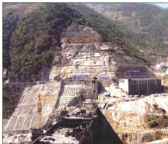
右坝肩开挖高边坡
