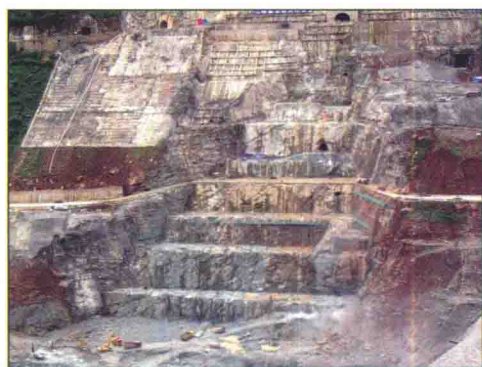
右坝肩开挖槽
