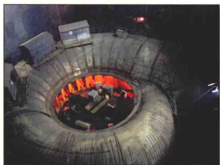
发电机组蜗壳安装
