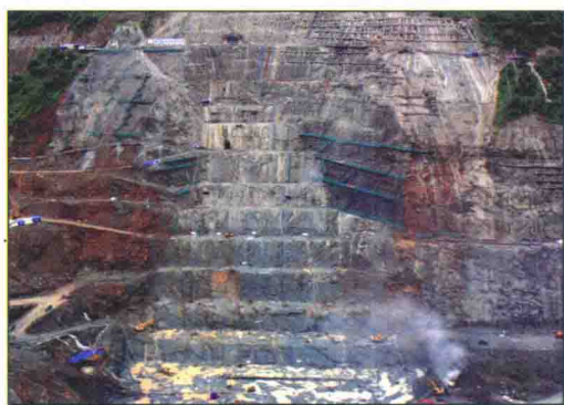
左坝肩开挖槽
