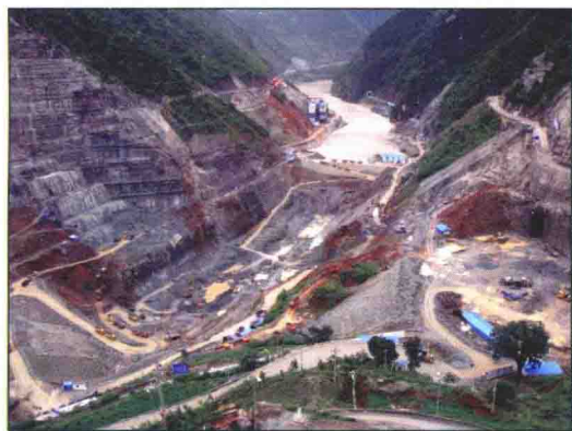
大坝开挖基坑
