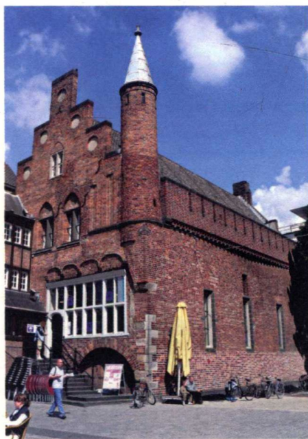
丹波斯的莫里安街屋，荷兰现存最古老的砖造建筑，建于13世纪。
