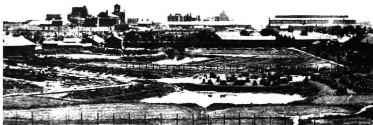
图 1-1 永利铔厂厂区全景图
