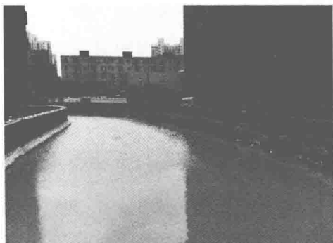
图 1-3 上海城市河流护岸工程景观
