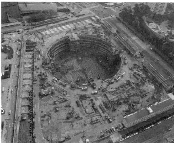
图7 塔楼区基坑开挖至坑底阶段照片
