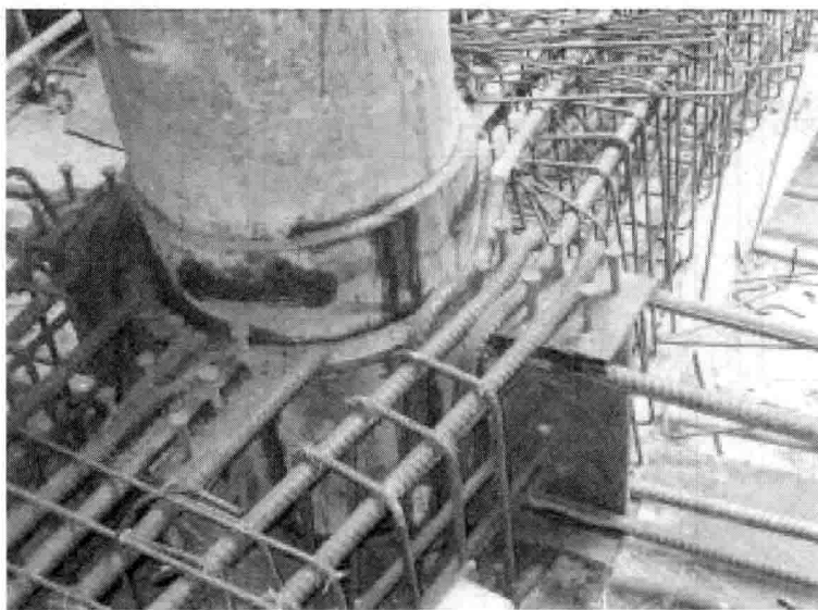
图 9 逆作法立柱与楼板梁连接节点大样
